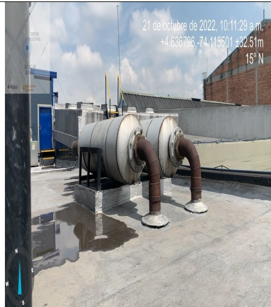
Fotografía 12. Ducto de salida de aire caliente del colector CP3.
