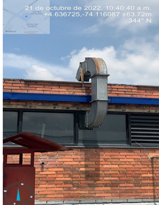
Fotografía 12. Ducto de salida de aire caliente del colector CP3.
