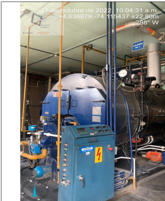
Fotografía 3. Caldera No. 1 Power Master de 100 BHP.
